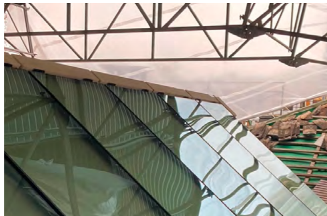
Villa Flora: Im Bild das neue Dach
