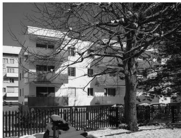
Die sanierte Liegenschaft Bürglistrasse 3+5.
