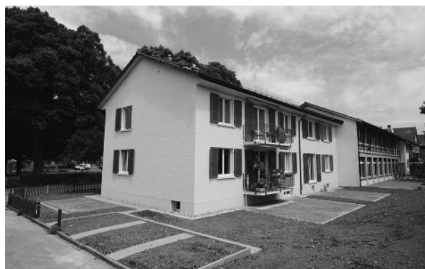
Die sanierte Liegenschaft Strittackerstrasse 31.
