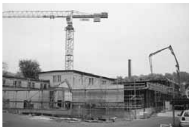
Metallarbeiterschule Zeughausstrasse: Baustelle Stand Ende Oktober 2003.
