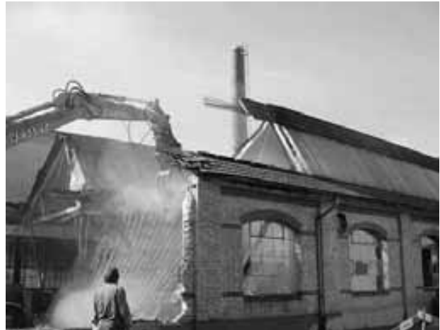
msw-Sanierung: Auf dass die alten Mauern fallen, um dem neuen Gebäude Platz zu verschaffen.
