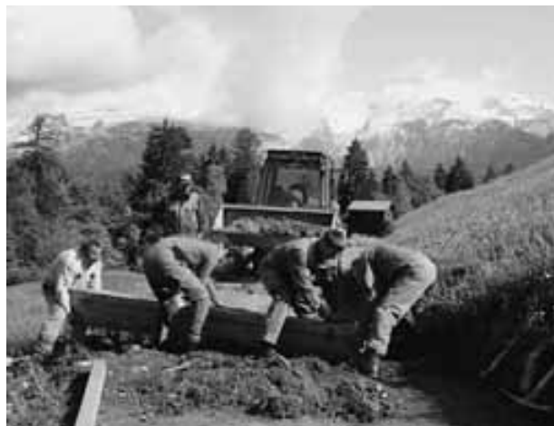
Wiederinstandstellungsarbeiten im Safiental (GR)
