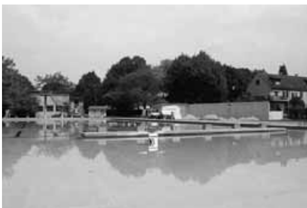
Rückbauten Freibad Geiselweid: Gesamtansicht
