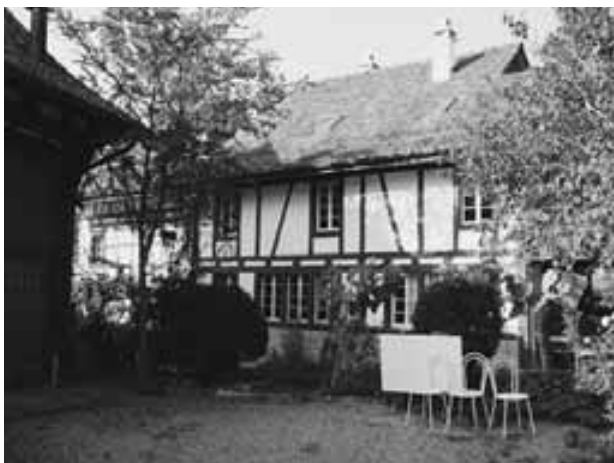
Armenhaus Veltheim, Ausserdorfstrasse 13, Fachwerkfassade nach der Renovation. Der im Bild zu sehende Teil des Armenhauses stammt aus der Zeit um 1850. Links aussen ist die reichere Fachwerk-Struktur des Bauernhauses an der Bachtelstrasse zu erkennen, das um 1650 errichtet worden war. Die inneren Strukturen des Ensembles konnten bei der Renovation weitgehend erhalten werden. Es ist ein spannendes Zeitzeugnis der Veltheimer Geschichte.
