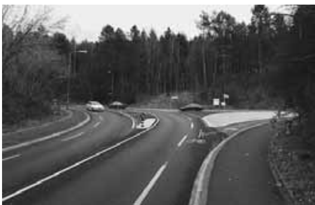
Auwiesenstrasse; Sanierung / Radanlagen
