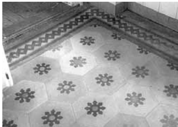
Arbeiterhaus Oberer Deutweg 41, Hörnlistrasse 1: Sanierter Küchenboden im Hausteil Hörnlistrasse 1. Die Zementplatten waren eine Spezialität des Erbauers und Unternehmers Huldreich Graf aus Winterthur, der auf der Schützenwiese eine Zementfabrik betrieb.
