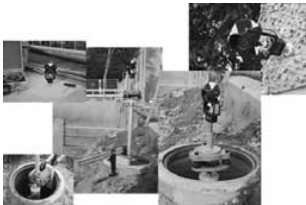
Baugrubenüberwachung im Eichgut-Areal
