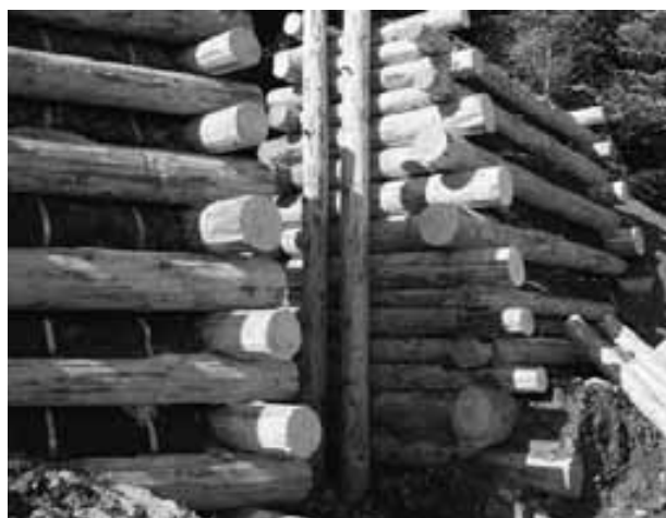
Vom Zivilschutz erstellte Hangsicherungen im Safiental
