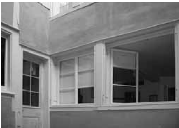
«Haus zum Tiger», Steinberggasse 33, Hinterhoffassade nach der Renovation. Die historischen Fenster sowie der Sumpfkalkverputz wurden sorgfältig renoviert und erhalten.
