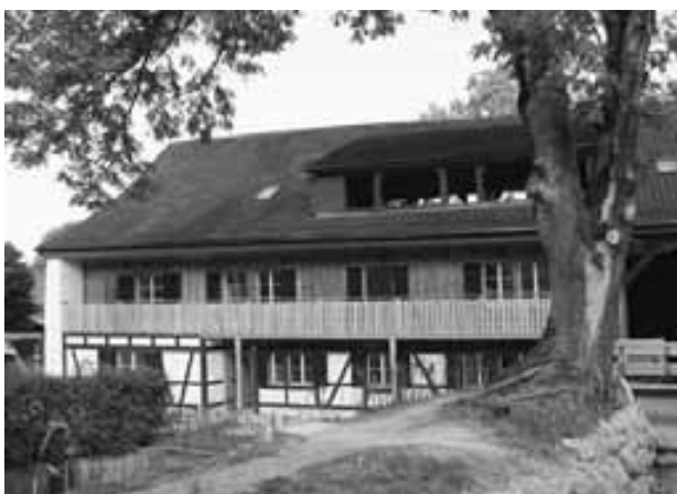
Mühle Hegi, Mettlenstrasse 28, nach der Renovation und dem Umbau des Wirtshauses «Zur Mühle» in ein Wohnhaus.
