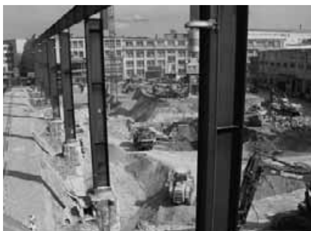
*Abb. 2 Baustelle beim Katharina Sulzer-Platz
