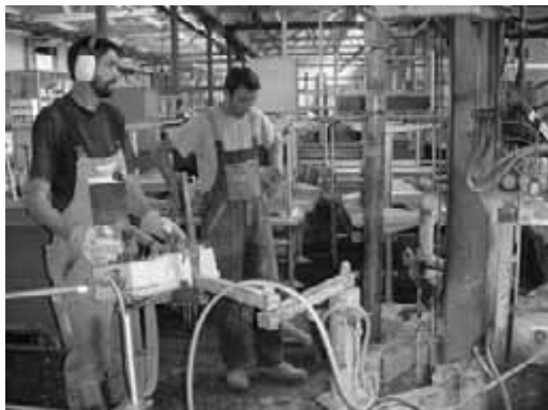
Untersuchungen des Baugrundes an der Zeughausstrasse
