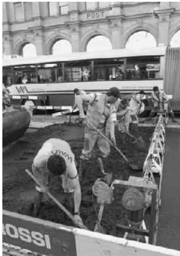
Bahnhofplatz: Einbau des Betonbelages für die Bushaltestellen
