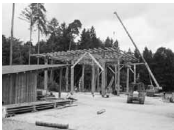
Bau des Holzschnitzelschopfes
