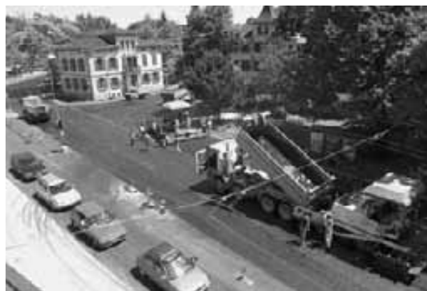
General Guisan-Strasse/Talegg: Einbau Deckbelag
