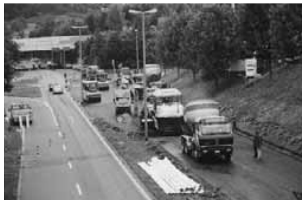
Salomon Hirzel-Strasse: Belageeinbau Fahrspur stadtauswärts.
