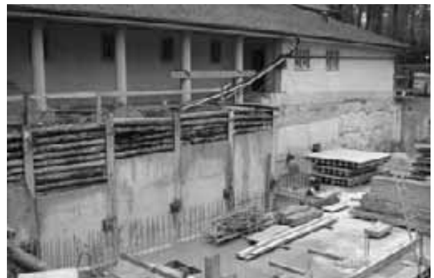
Neubau Krematorium: Baugrube neben der bestehenden Abdankungskapelle
