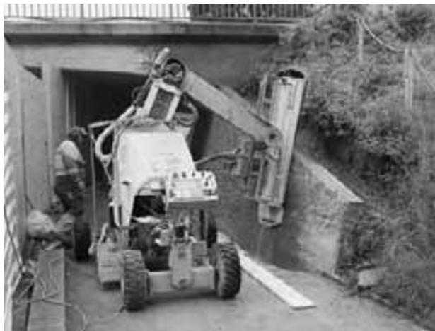
St. Gallerstrasse, Brücke über Seenerstrasse: Bauwerkerhaltung, Betonabtrag mit Wasserhöchstdruck
