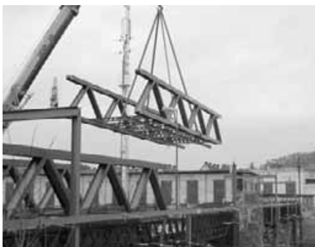
Wylandbrücke: Montage eines Stahlfachwerkelementes der neuen Brücke über die bestehende Brücke
