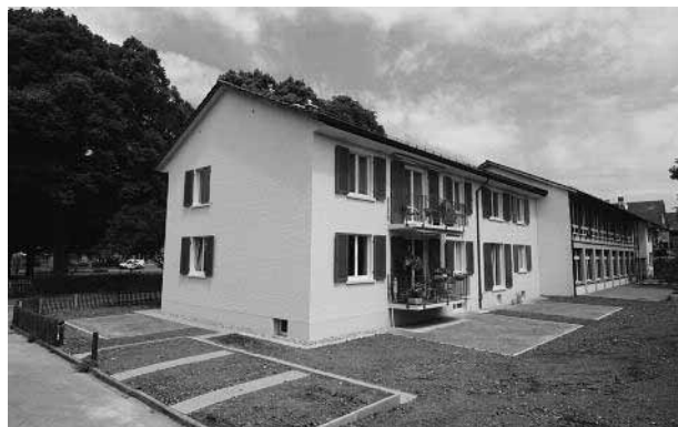
Die sanierte Liegenschaft Strittackerstrasse 31.
