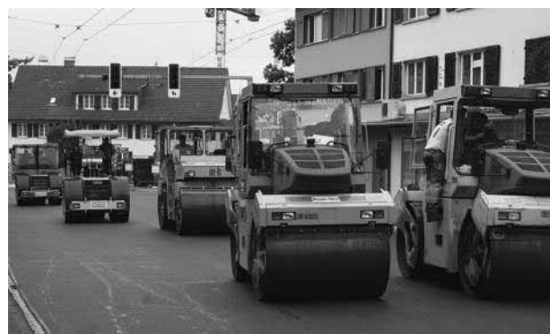
Beeindruckendes Walzenspiel beim Deckbelagseinbau Tösstalstrasse.
