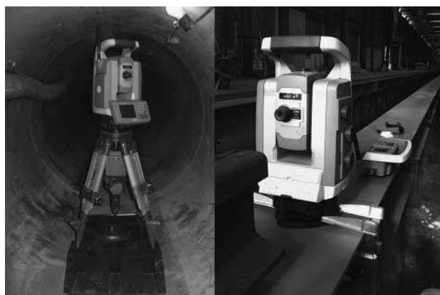
Spezielle Tachymetermontagen beim Kanal- und Gleisbau.
