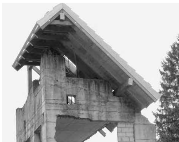
Schrägdach auf der Mehrzweckstation im Ohrbühl
