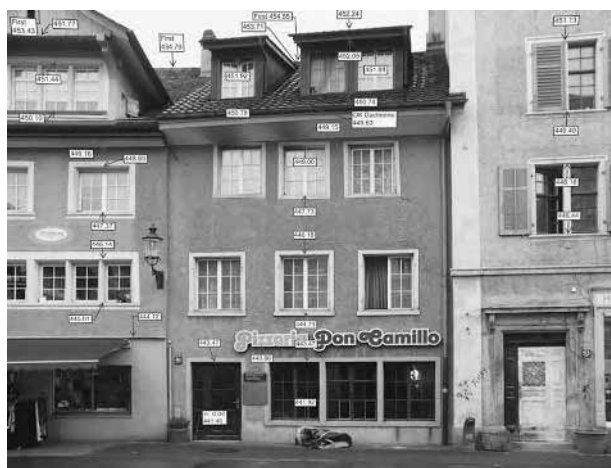
Fassadenaufnahme im Altstadt kern
