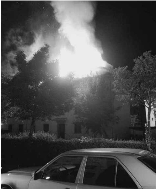
Grossalarm; Grossbrand mit Durchzündung des Dachstocks, 67 AdF im Einsatz
