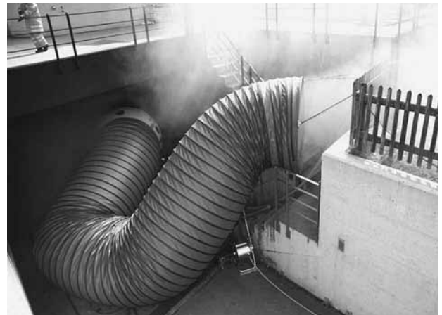
Tiefgaragenbrand in Elgg, regionaler Einsatz mit Grosslüftermodul
