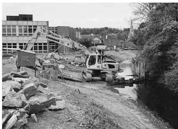
Baubeginn der zweiten Etappe Eulachpark
