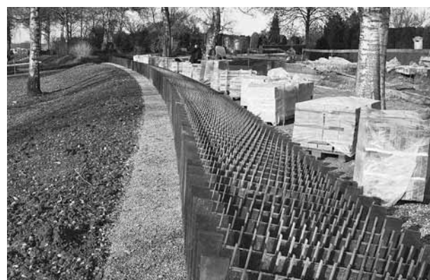
Bau des Gemeinschaftsgrabes im Friedhof Rosenberg; auf diese Stahlträger werden die Namensplatten gelegt.
