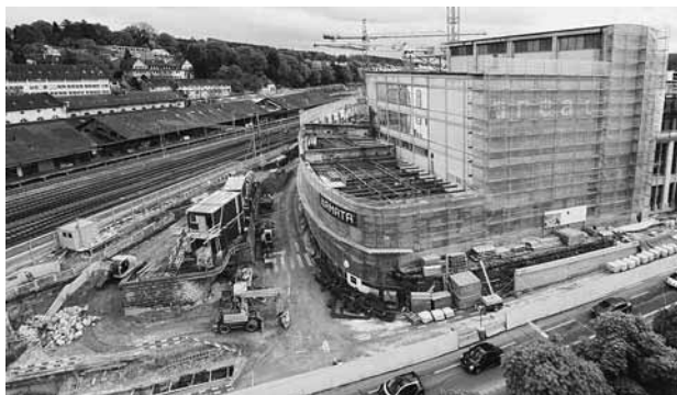
Bauarbeiten bei der Gleisquerung Stadtmittte, 1. Etappe
