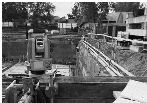
Überwachungsmessung Rühlwand, Baustelle Rosenberg
