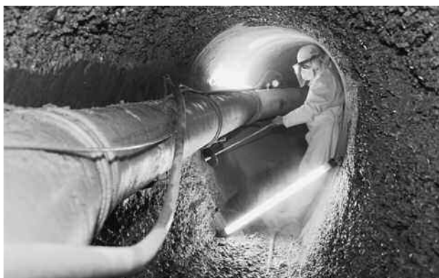
Kanalerneuerung / manuelle Kanalinnensanierung, Rebwiesenstrasse
