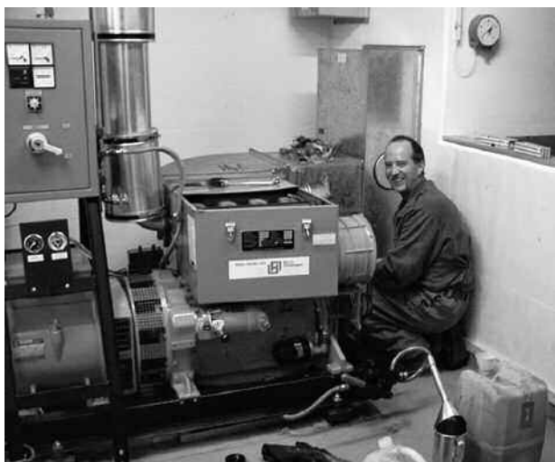
Anlagewartung Notstromdiesel
