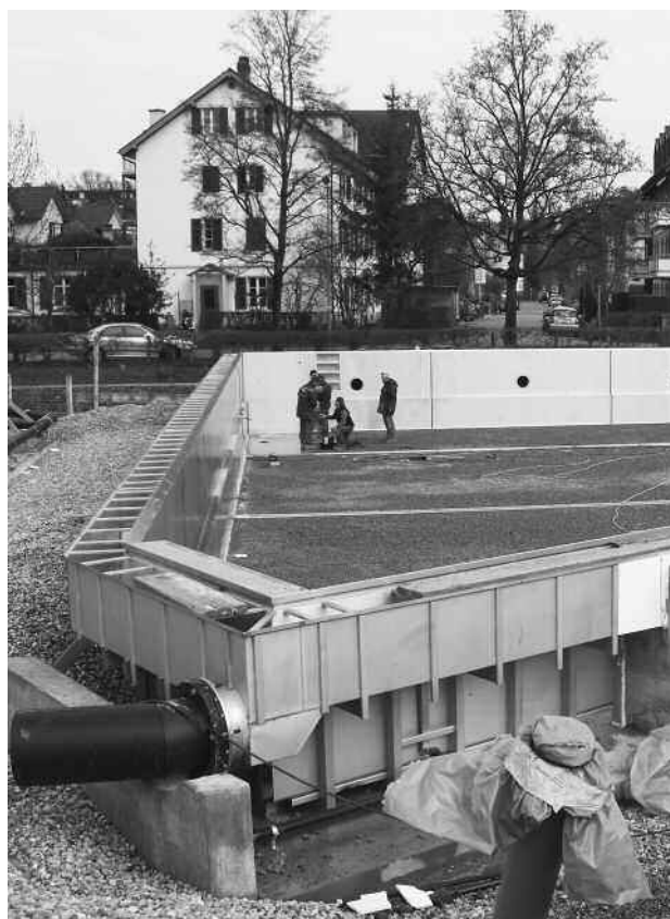
Umbau Schwimmbad Geiselweid
