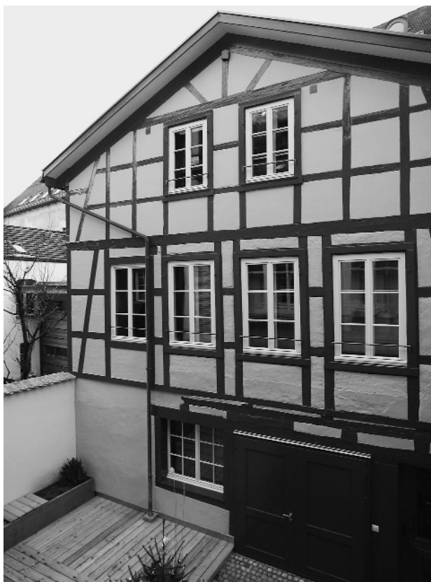
Das renovierte Hinterhaus der Tösstalstrasse 6 und 8
