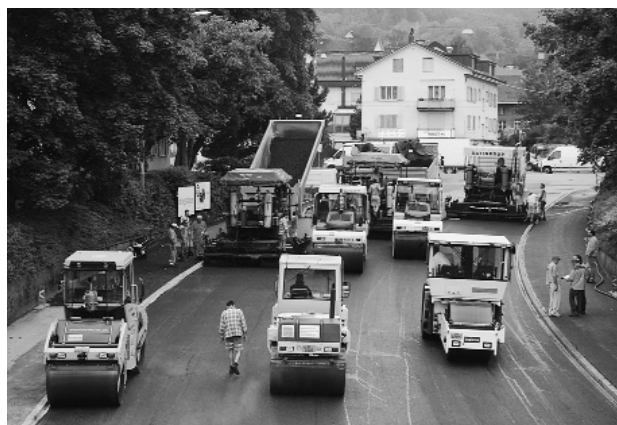
Belageinbau am Knoten Frauenfelderstrasse/Seenerstrasse
