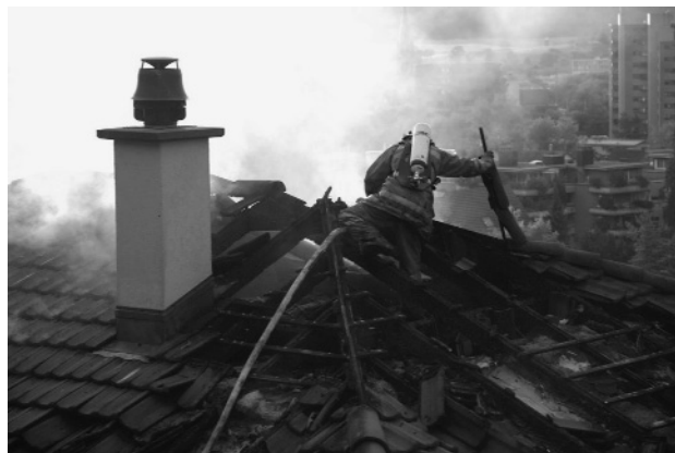
Dachstockbrand an der Kurlistrasse am 30.6.07
