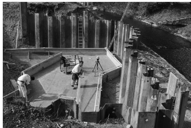
Bau einer Sitzbühne an der Eulach. Infolge der Hochwassergefahr mussten die Bauwerke mit Spundwänden gesichert werden.
