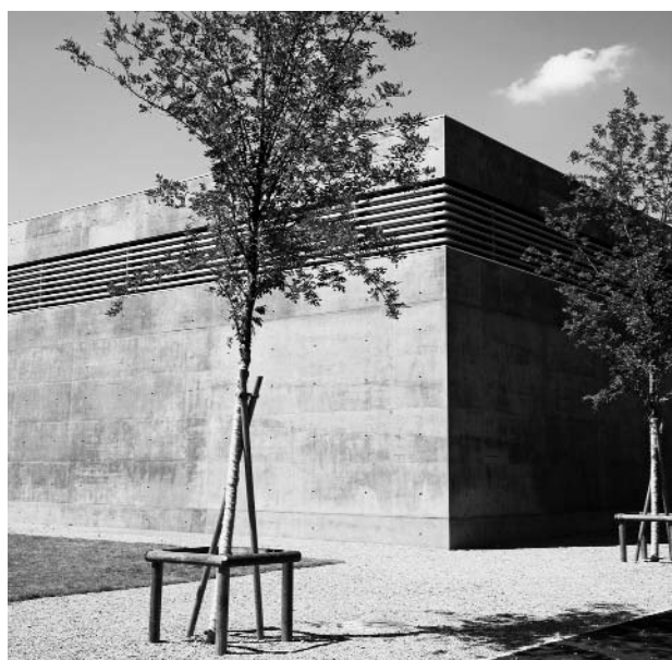
Höhere Versorgungssicherheit im Raum Wülflingen dank des neuen Unterwerks.
