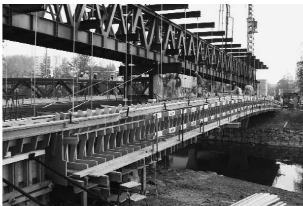
Erschliessung des Quartiers Niederfeld durch die Johannes-Beugger-Brücke.
