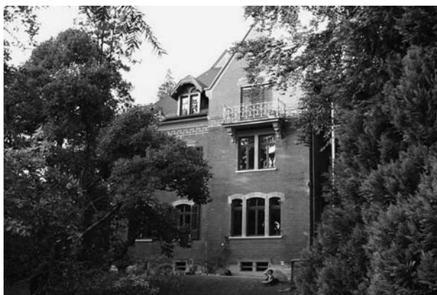
Villa Gottfried Kellerstrasse 67, nach der Renovation. Südfassade gegen den Garten mit Balkonanbau an der Ostfassade.
