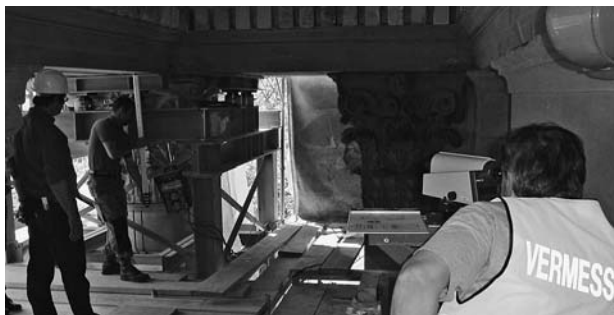
Bauwerksüberwachung an den Säulen des Stadthauses
