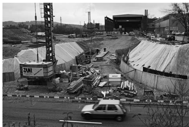
Sulzer-Allee/Seenerstrasse, Verbindungsstrasse West bis Else Züblin-Strasse
