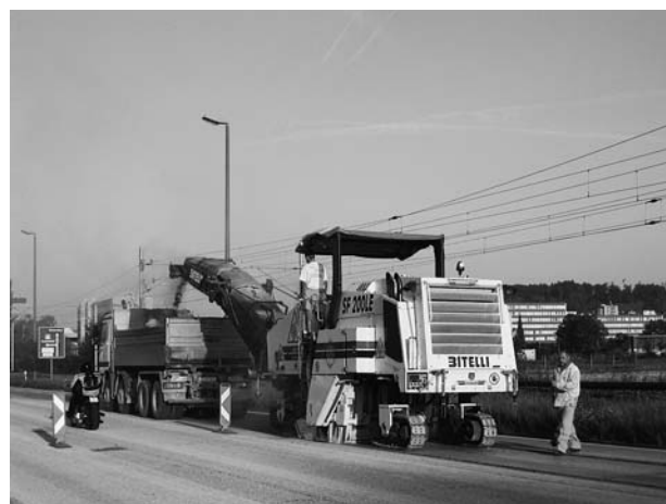
Belagsfräsen St. Gallerstrasse
