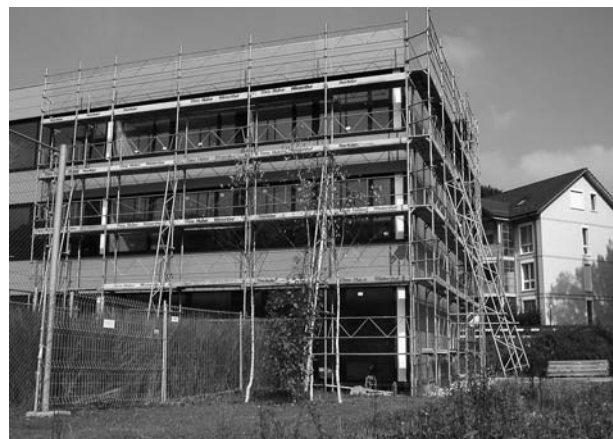
Erweiterung Schulhaus Laubegg, Südwestfassade
