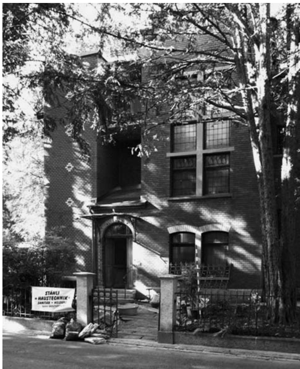
Villa Gottfried Kellerstrasse 67, nach der Renovation. Nordfassade mit Liftschacht-Anbau in Backstein.
