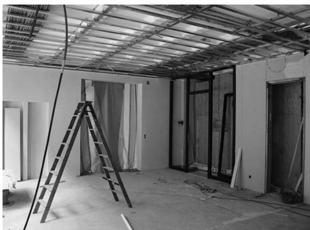
Umbau Parterre Lagerhausstrasse 6
