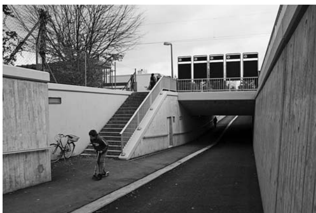
Stofflerenweg, Personenunterführung SBB, Instandsetzung
