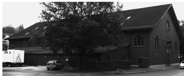
Mehrzweckanlage Teuchelweiher, grosse Reithalle
