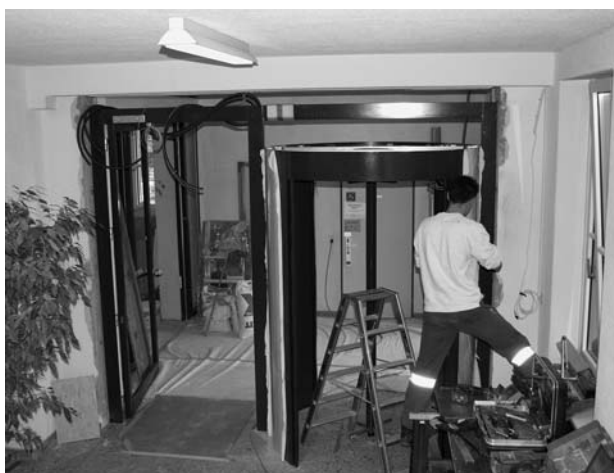
Umbau Parterre Lagerhausstrasse 6: Einbau der Drehtüre
