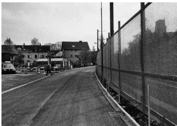
Kiesstrasse, vor Einbau Deckbelag
