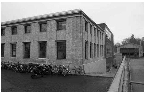
Metallarbeiterschule Zeughausstrasse, Renovierter Altbau vom Eulachraum her.
