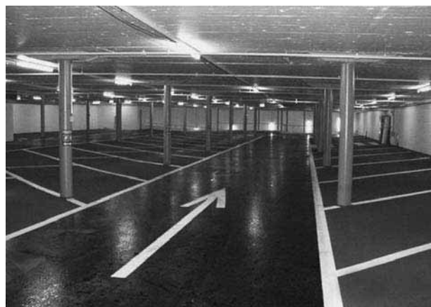
Parkgarage Technikum Nord, 1. Parkgeschoss vor Inbetriebnahme
