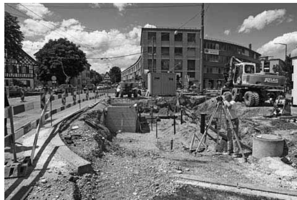
Zwingliplatz, umfangreiche Werkleitungsbauten
