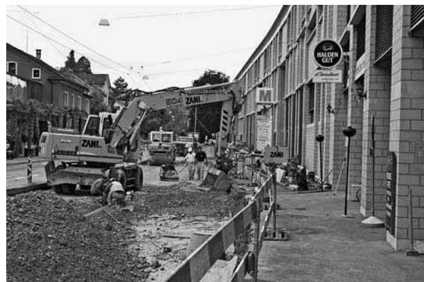
Zwingliplatz, Bauarbeiten Bereich neue Bushaltestelle
