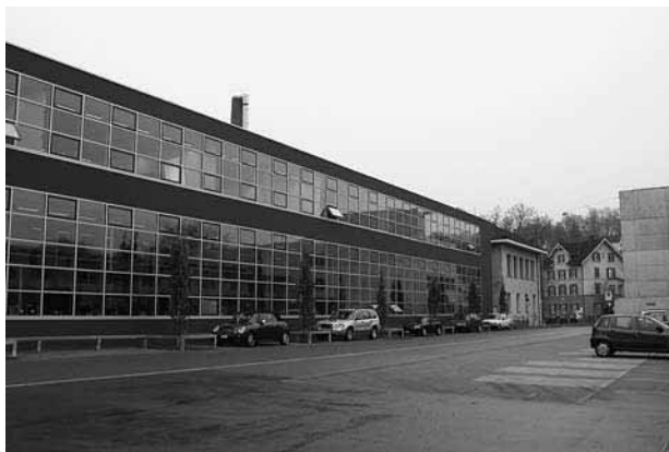
Metallarbeiterschule Zeughausstrasse, Werkstatttrakt
