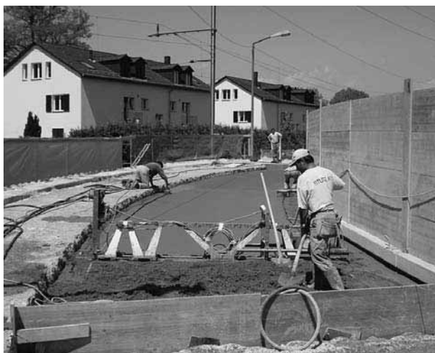
Brücken Technorama, Betonieren Fahrbahn
