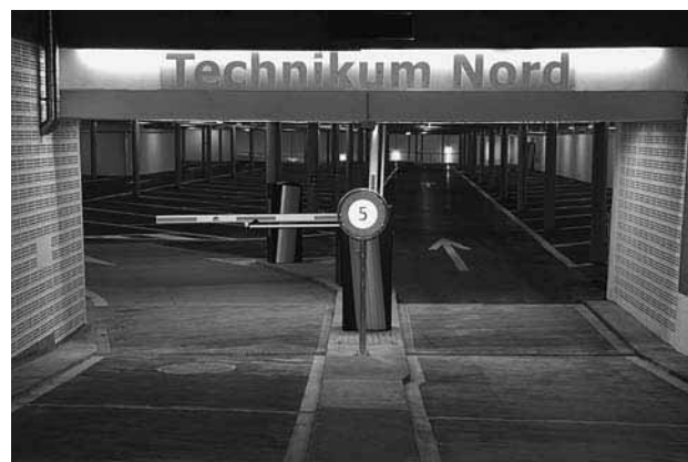
Sanierung des Parkhauses Technikum Nord
