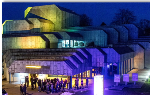
Sanierung Theater Winterthur
