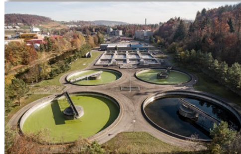
Sanierung Abwasserreinigung (ARA)
