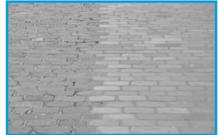
Pflasterung, Oberfläche geflammt, Granit 9/11, barrierefrei
