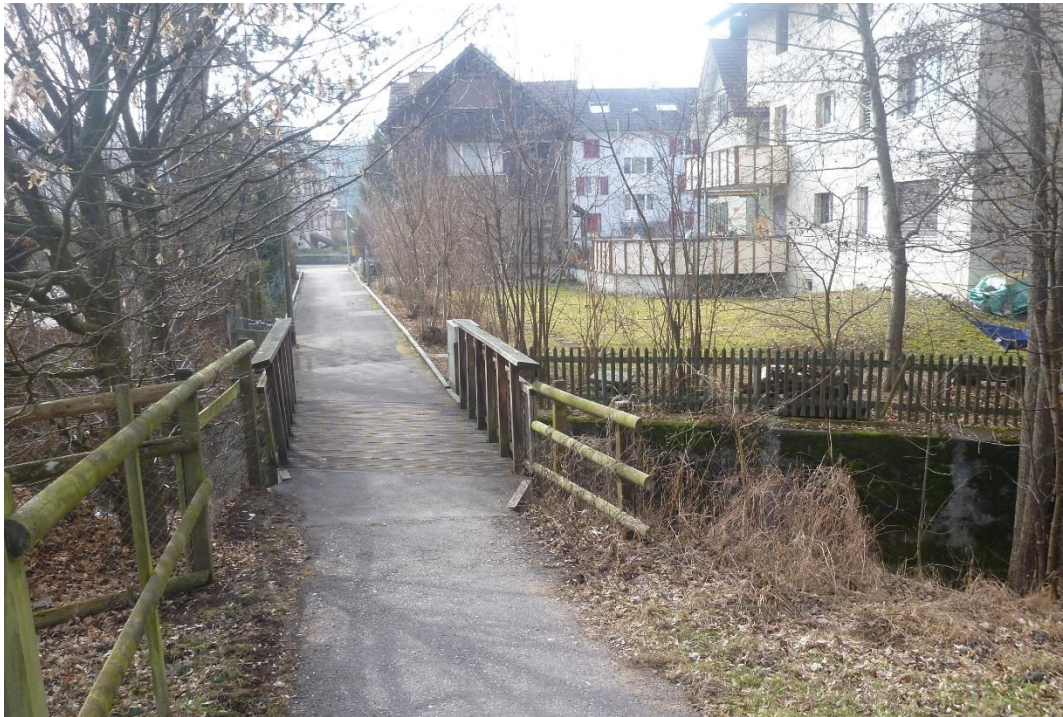
Abbildung 8: Fussgängersteg Büelhofweg - Korrosionsschutzobjekt
