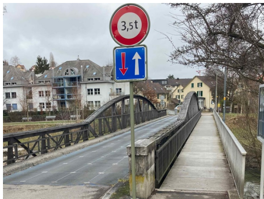
Bild 1a: Westseitige Signalisation
