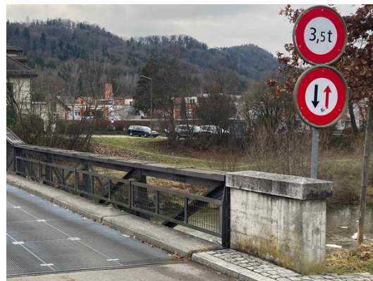
Bild 1b: Ostseitige Signalisation
