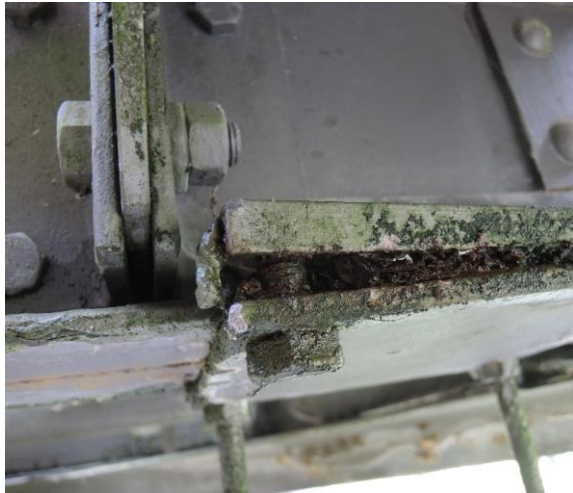
Abbildung 21 – Fehlende Mutter bei Aufhängung, Achse B-B
