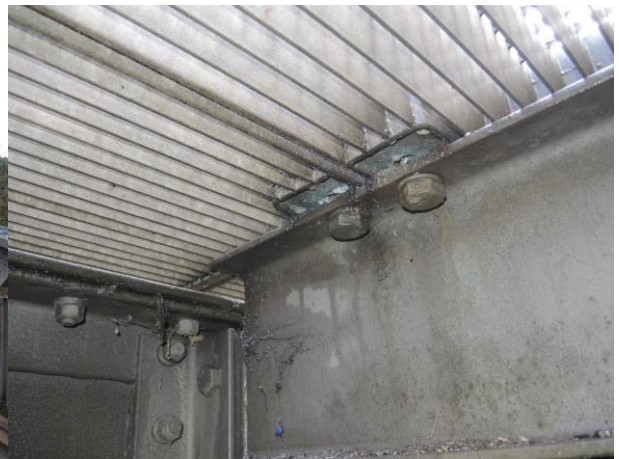
Abbildung 28 - Schraubverbindung Gitter und Träger
