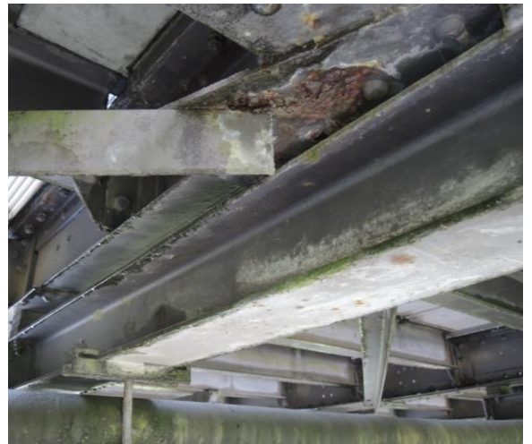
Abbildung 11 - Kreuzverband Achse E-E
