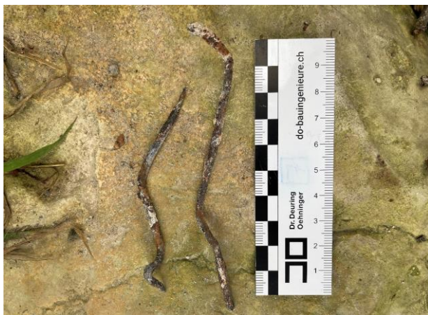
Abbildung 35 – Sondieröffnung S1, Bewehrung
