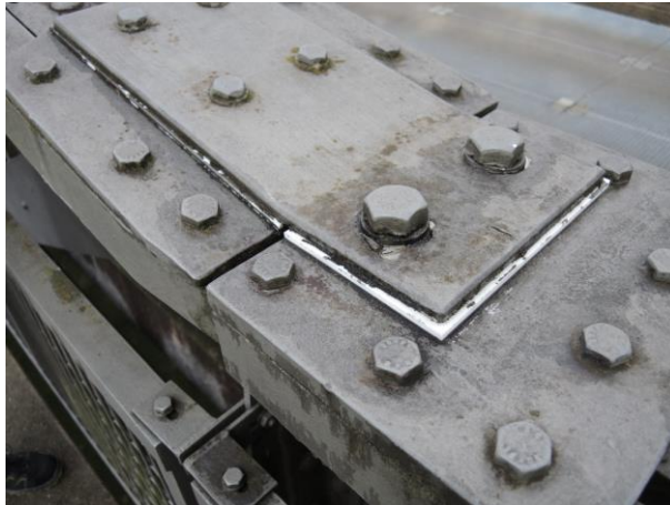
Abbildung 29 - Gleitlager
