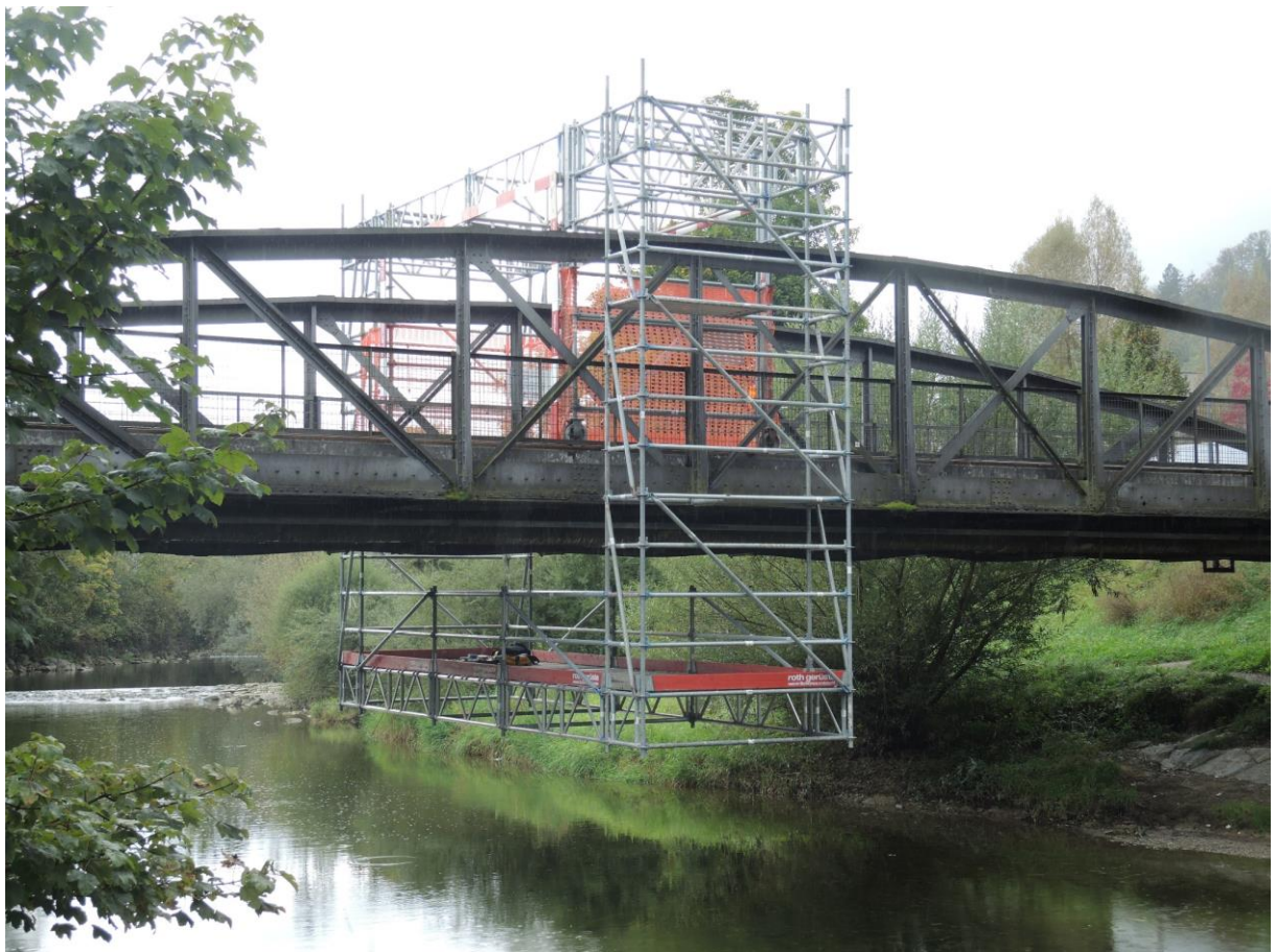
Abbildung 7 - Gerüst zur Prüfung Brückenuntersicht und Überbau
