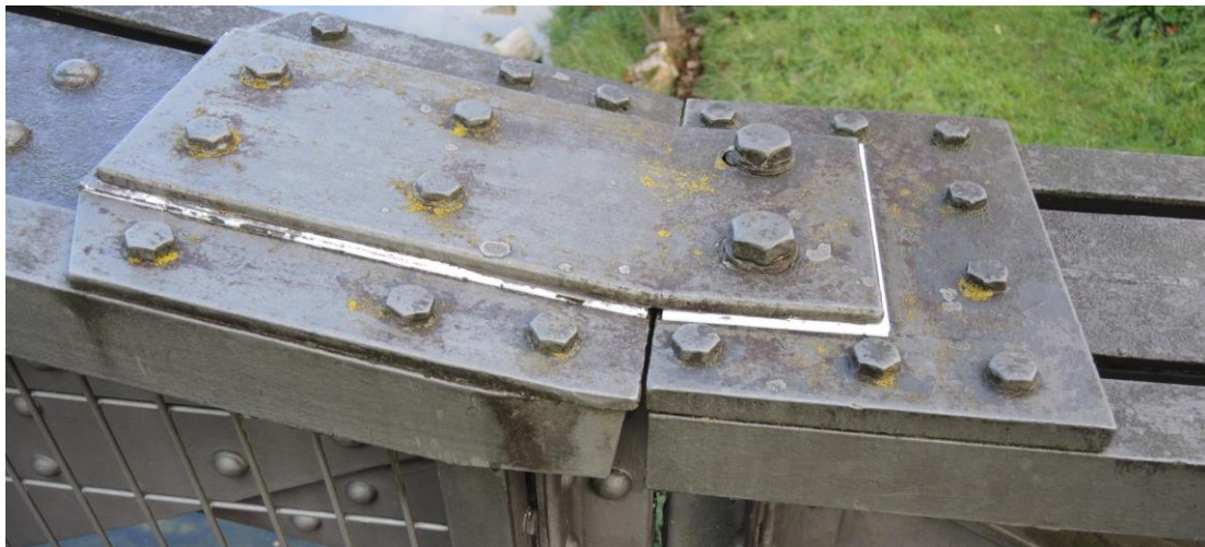
Abbildung 11 – Moosbildung auf Obergurt (hier bei Gleitlager Übergang Hauptöffnung – Vorlandbrücke)
