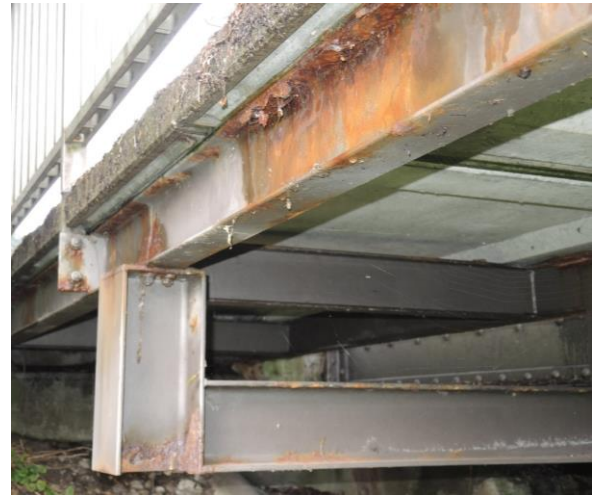
Abbildung 14 - Aufhängung und Längsträger, Achse A-A
