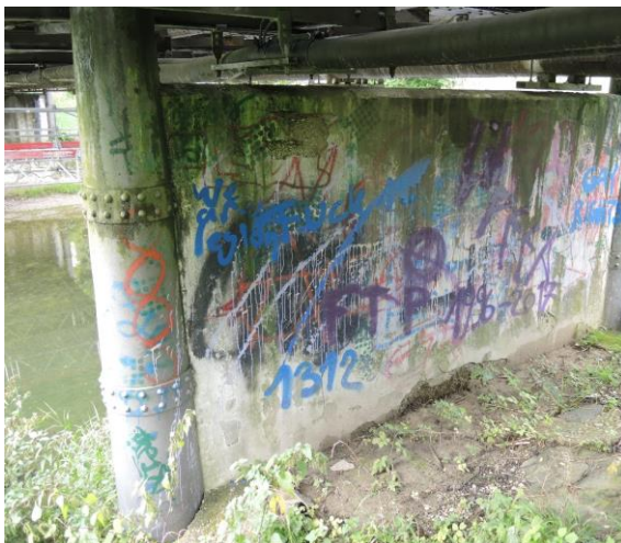
Abbildung 19 – Wand, Uferseite Töss
