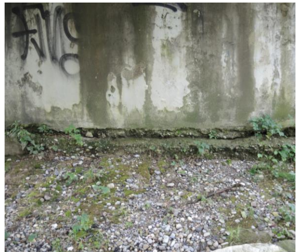
Abbildung 18 – Fundament, Uferseite Nägelsee
