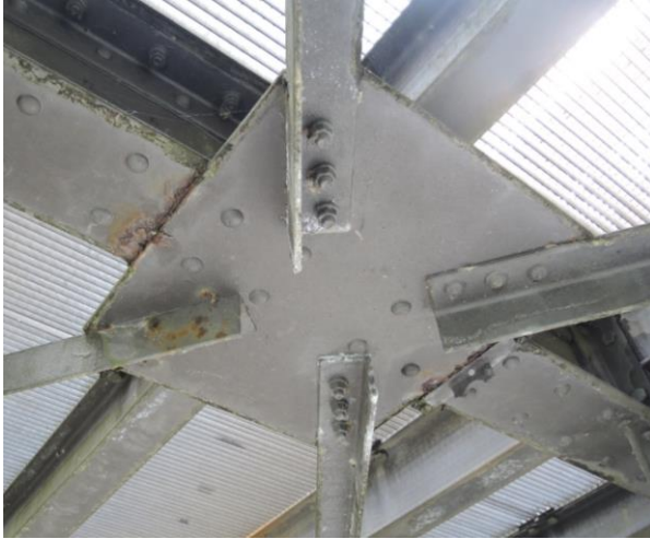
Abbildung 8 – Kreuzverband Achse C-C
