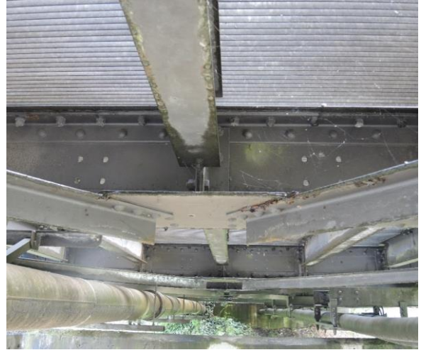
Abbildung 9 – Kreuzverband Achse E-E
