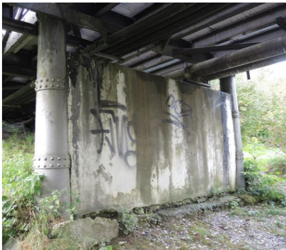
Abbildung 17 – Wand und Fundament, Uferseite Nägelsee
