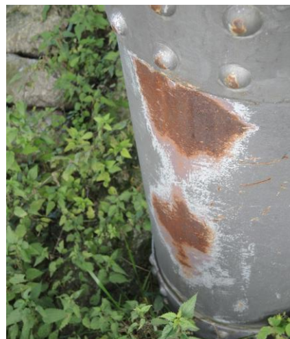
Abbildung 20 – Stütze 4, Korrosionsbereiche
