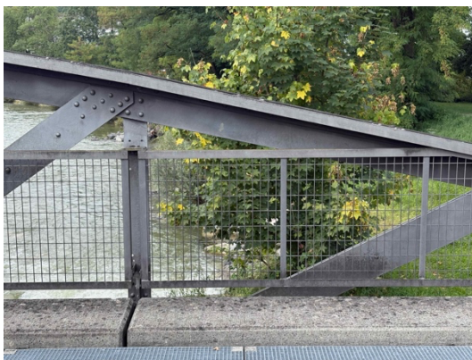
Bild 2: Absturzsicherung in der Brückenmitte
