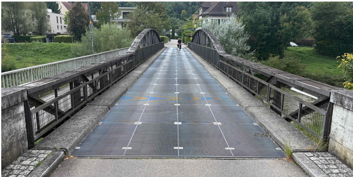
Bild 1: Metzgerbrücke über die Töss in Blickrichtung Nägelsee (Fussverkehrsstege links)
