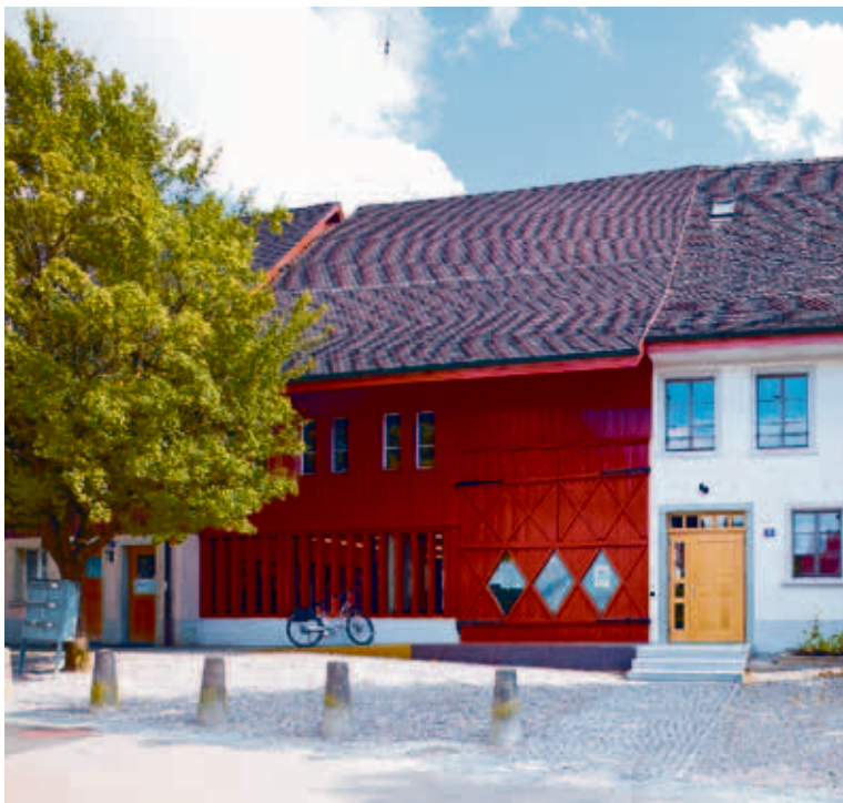
▲ Das Gebäude der ehemaligen Untervogtei beherbergt heute die Kreisbibliothek sowie Teile der Stadtverwaltung. | Bild: Michael Lio
