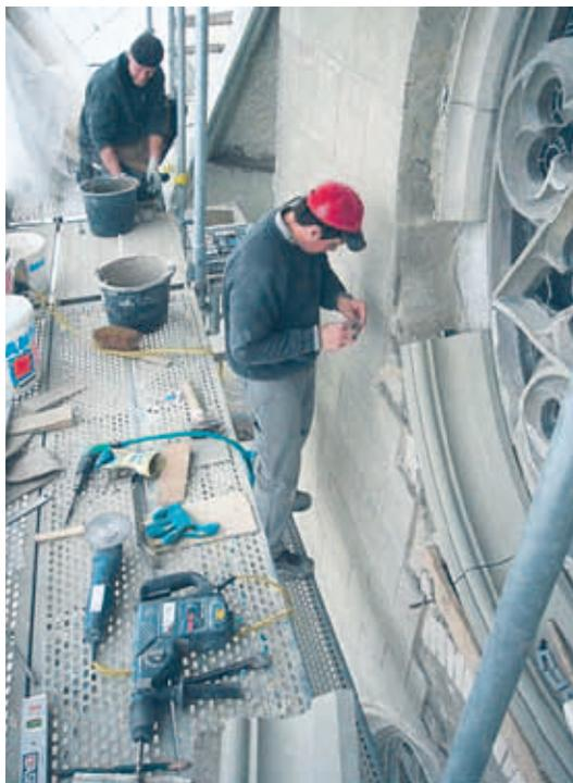
▲ Restaurieren der Fensterrosette, Steinmetze an der Arbeit auf dem Gerüst (Teilersatz, Aufmörtelung) | Foto: Johann Frei
