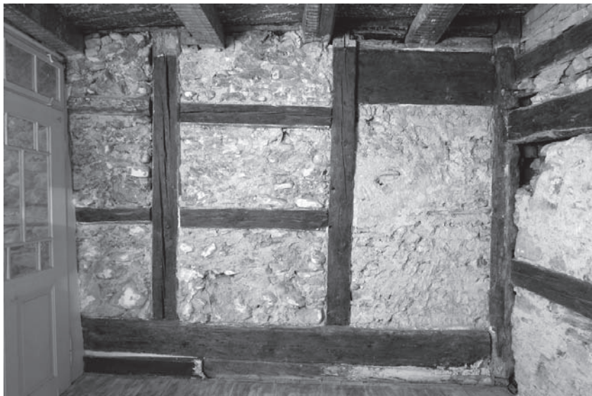
Obere Hohlgass 15: Ansicht der Trennwand zwischen Wohnteil und ehemaligem Tenn. Die Grundkonstruktion stammt noch vom Bohlenständerbau von 1510. Um 1581 wurden die Bohlen durch ein Fachwerk mit Türe ersetzt.
