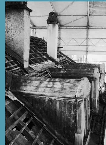
Dachsanierung Wohnhaus Corti
