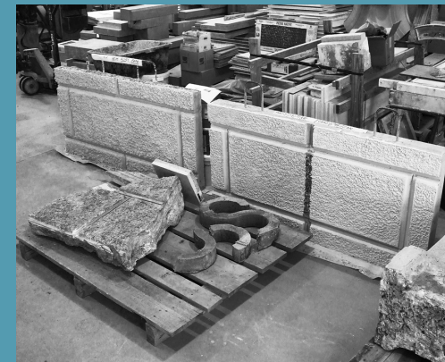
Restaurierung Gartenmauer Wohnhaus Corti
