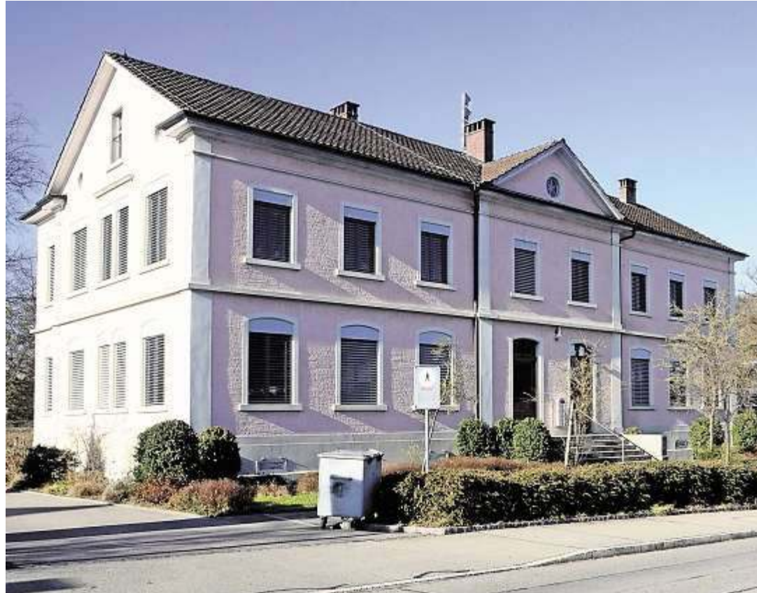
Letztmals 1987 saniert: Das alte Schulhaus an der Dorfstrasse wird weiterhin von der Gemeinde genutzt. Marc Dahinden
