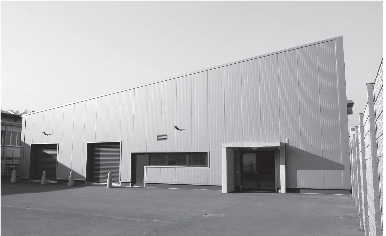
Im Rechenzentrum Schaffhausen kann 2015 das zweite Rechenzentrum für die Stadt Winterthur untergebracht werden.
