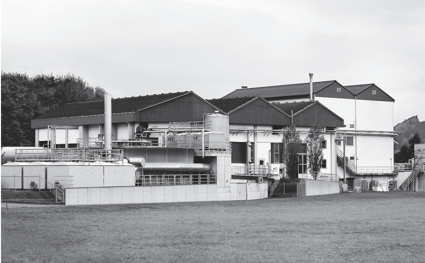
Die Biogasanlage von Biorender.
