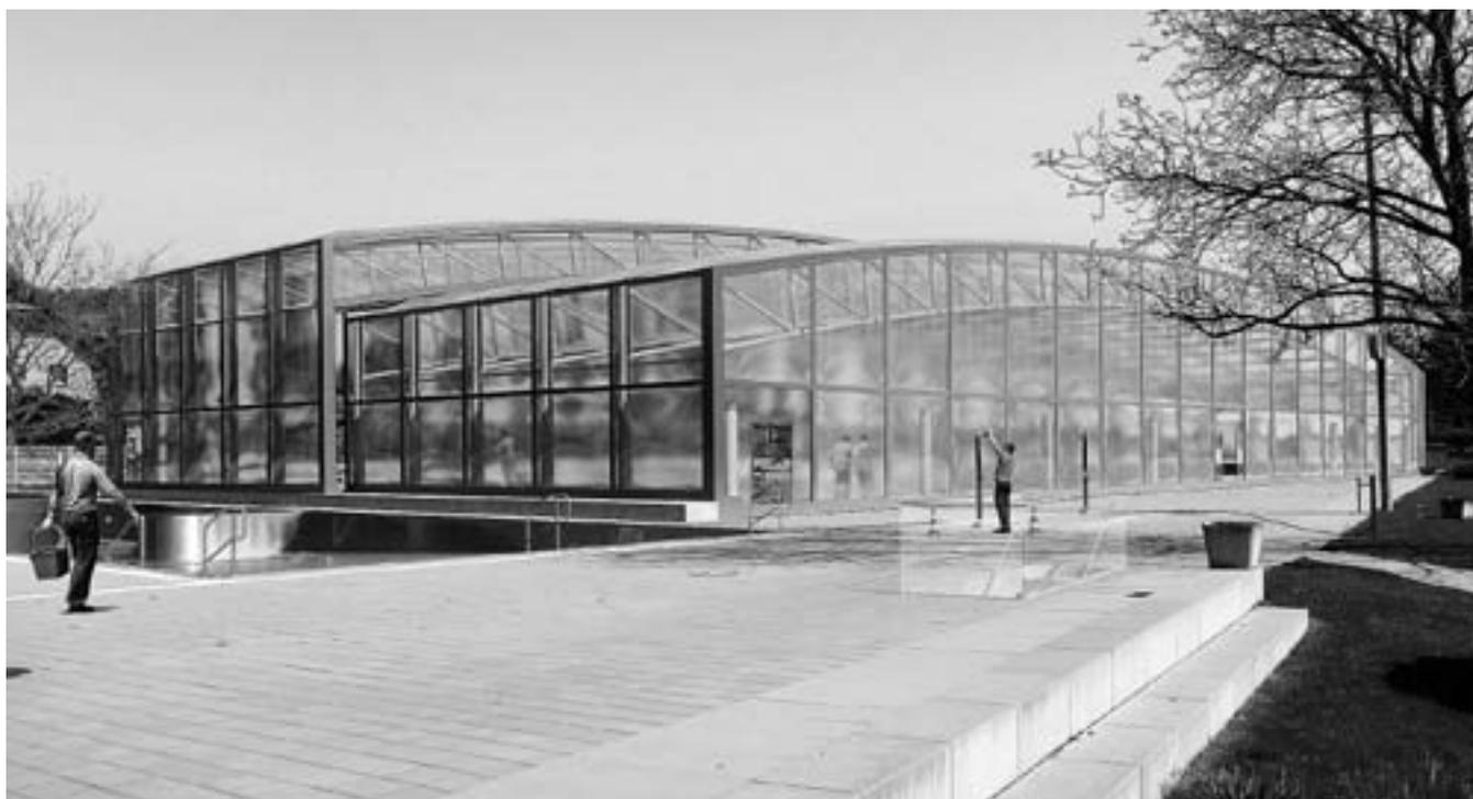
Das Olympiabecken im Freibad Geiselweid wird im Winter überdacht. Das Dach besteht aus einer Stahlkonstruktion mit lichtdurchlässigem Foliendach.
