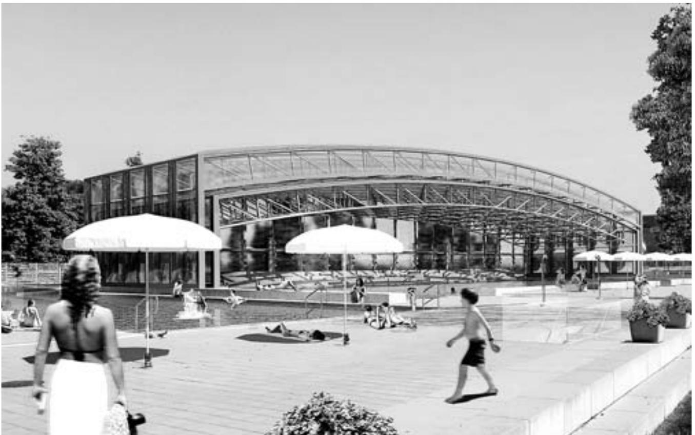
Das Cabriodach im Sommer: Die Seitenwand wird demontiert, das Dach zurückgeschoben. Das Becken kann als Teil des Freibades genutzt werden.
