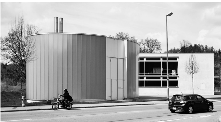
Die Holzschnitzel-Heizanlage in Sennhof liefert Wärme für Schulhaus und umliegendes Quartier.
