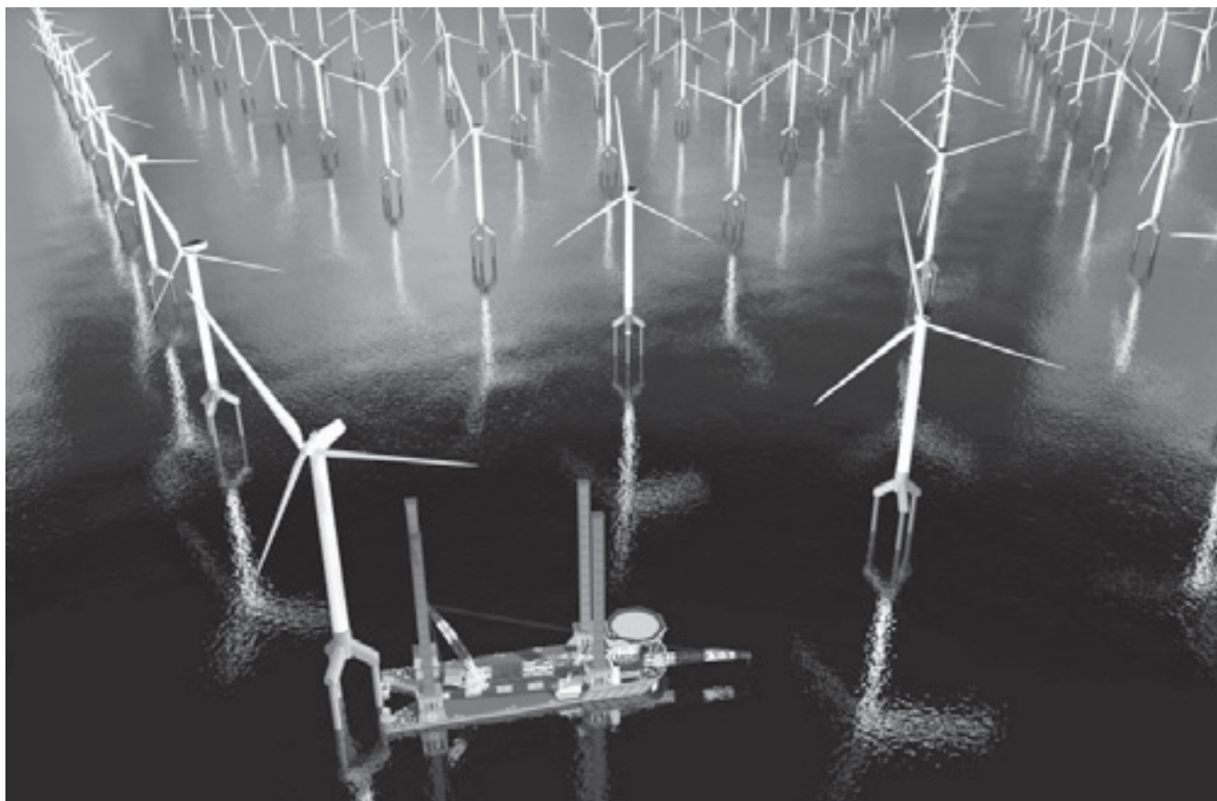
80 Windturbinen werden dereinst in der Nordsee umweltfreundlichen Strom für 400 000 Haushalte erzeugen. Im Bild das speziell für die Realisierung des Windparks «Ocean Breeze» erstellte Errichterschiff.
