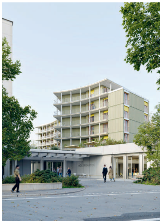
Der neue Haupteingang im Verbindungsteil zwischen dem heutigen Alterszentrum (linker Bildrand) und dem Neubau (im Hintergrund).
