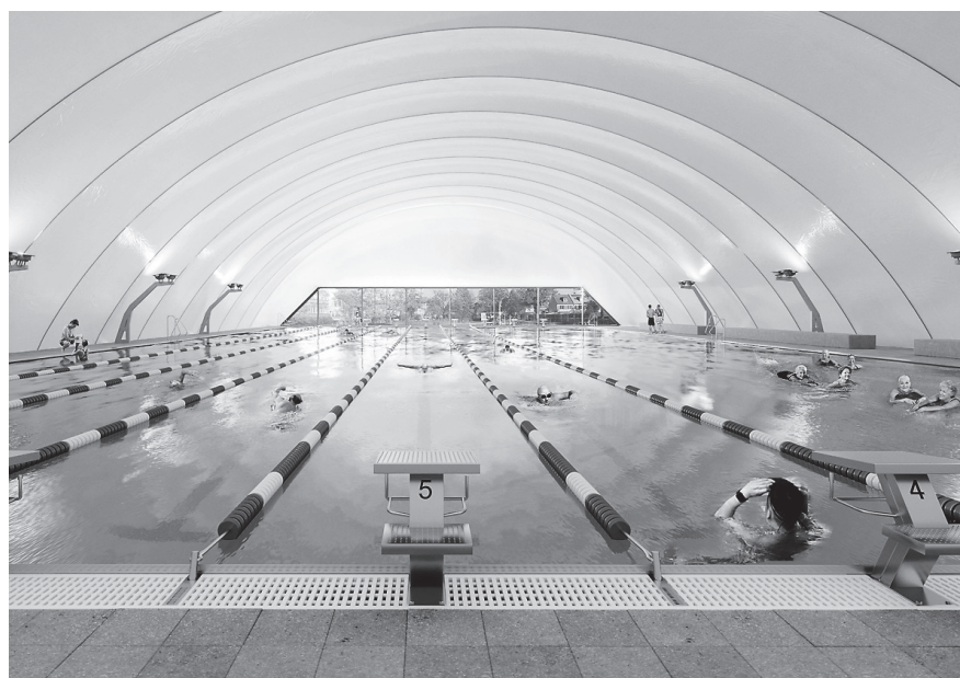
Während des Winterhalbjahrs wird über dem Olympiabecken des Freibades Geiselweid eine Traglufthalle errichtet (Visualisierung).
